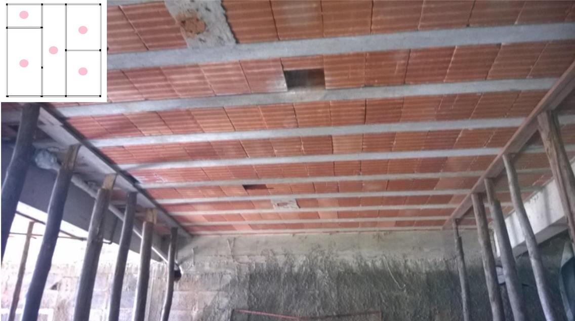
**Figura 7 – Lajotas que se soltaram, indicando uma flexão nas vigotas, possivelmente causadas pela flexão nas vigas de apoio.**
