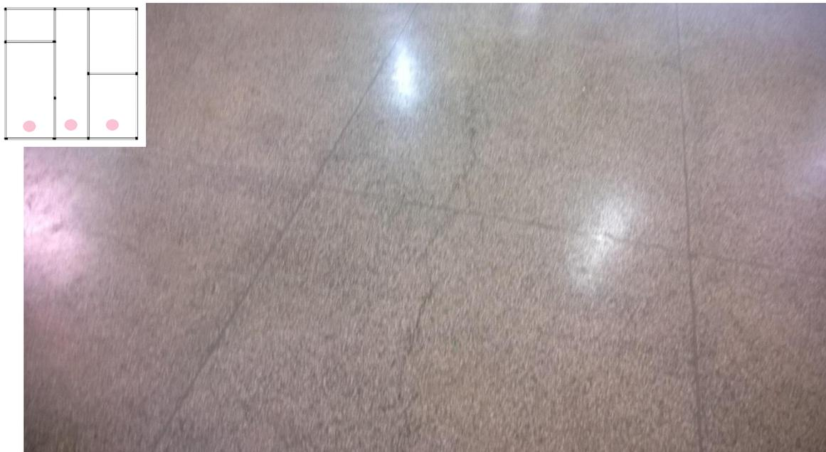
**Figura 3 - Trincas no piso**
