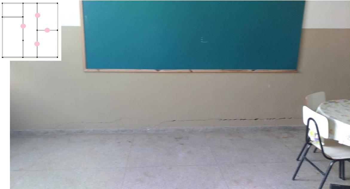
**Figura 2 – Rachadura gerada pelo descolamento.**
