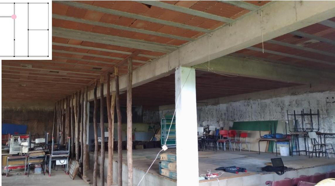
**Figura 12 – Visão Geral das Estruturas – Pilares, Vigas e Laje Trelaçada.**
